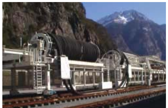
Гигантские барабаны для строительства тоннеля San Gothard, Швейцария.
