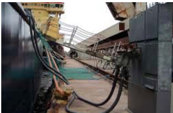
Разъёмы Cavotec в порту Гётеборга, Швеция
