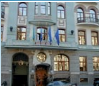
Пятизвездочная гостиница «Премьер палас» в Киеве оснащена распределительными щитами Modan и оборудованием «Моэллер».
