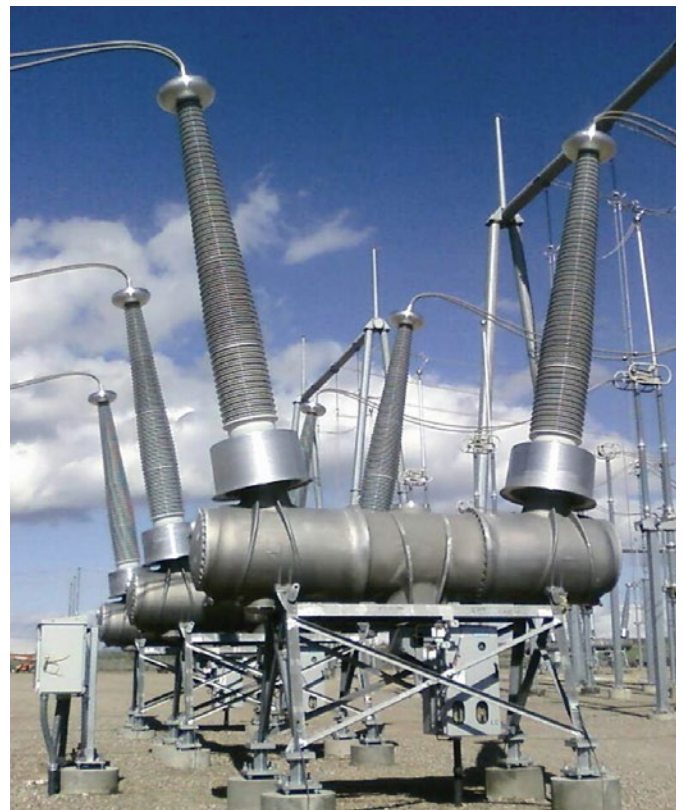
Fig. 4.1-15: 3AP2 DT 550 kV
