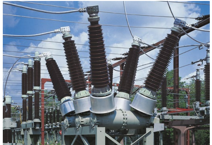
Fig. 4.1-12: SPS2/3AP1 DT 145 kV
