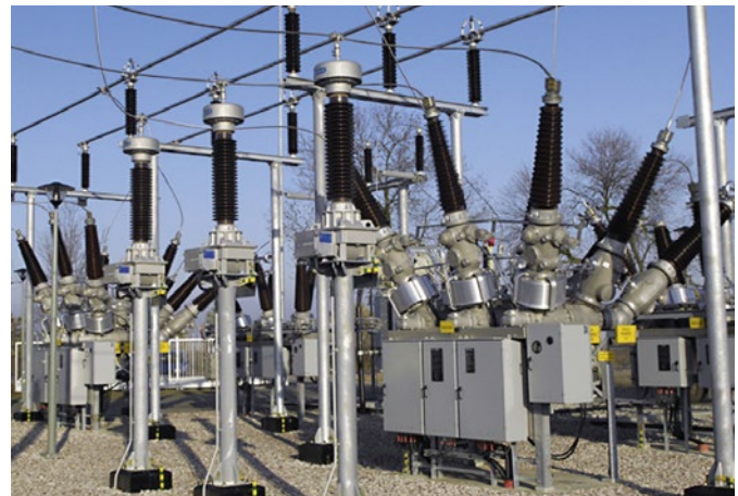
Fig. 4.1-17: 3AP1 DTC 145 kV
