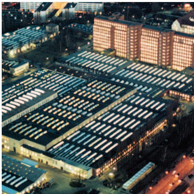
Завод по производству распределительных устройств в Берлине, Германия
