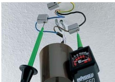
Проверка напряжения в клеммах для светильников
