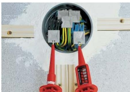
Проверка напряжения в клеммах для распределительных коробок
